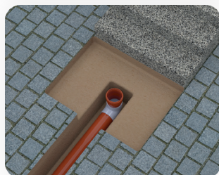
Монтаж піддона з трубою для відходу в дощову каналізацію
